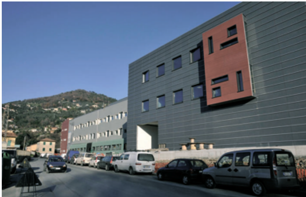
La facciata del nuovo ospedale di Rapallo
